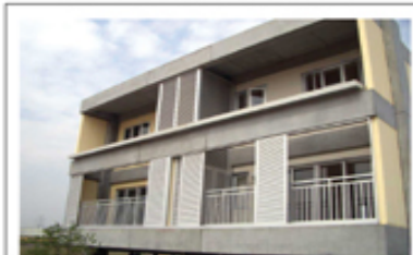
万科工业化住宅 第2号试作栋（东莞市）
